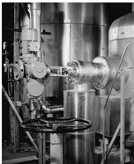
核电站高压预热器的凝结水排放控制阀 ZK 29
