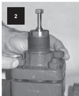
Palcami dokręcać równomiernie parami przeciwnie nakrętki
