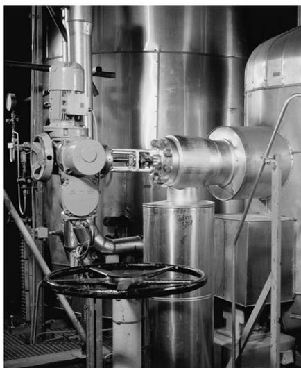
Precalentador de alta presión en central nuclear equipado con válvula ZK 29 para regulación del drenaje
