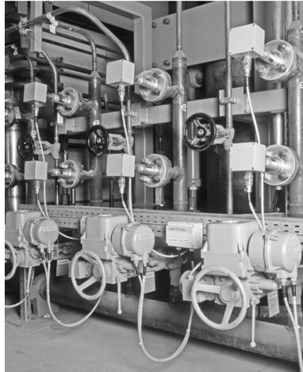
ZK 29 mit elektrischem Antrieb in einer Entwässerungs-/Ablaufregelstation
