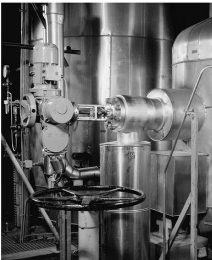
Kondensatablauf-Regelventil ZK 29 am Hochdruckvorwärmer eines Kernkraftwerkes
