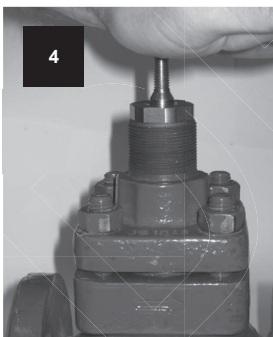
Kegelstange fest und schnell nach unten drücken.
